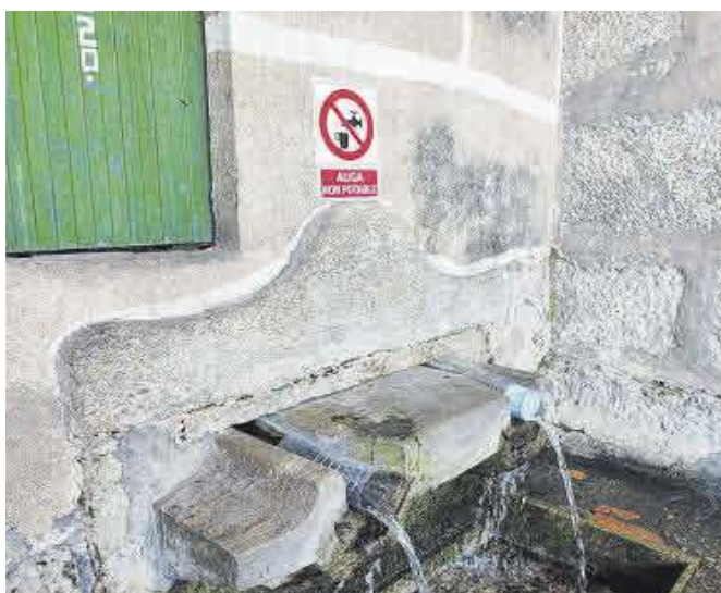
Cartel de agua no potable en la fuente de Fontecán. | S.Á.
