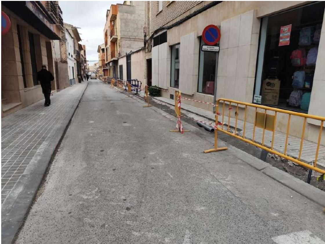
Bolaños acelera las obras de mejora de abastecimiento de agua
