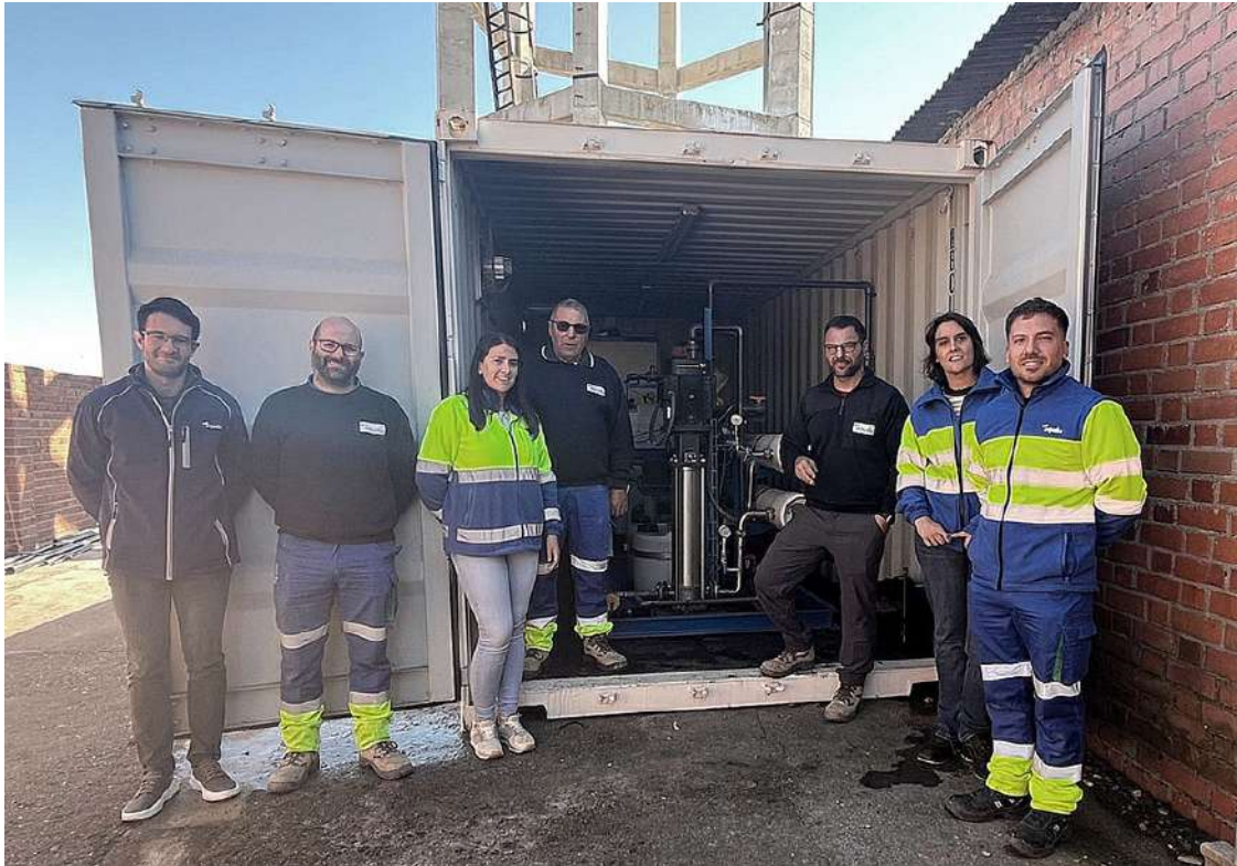
Equipo de trabajo en la ETAP de Tiñosillos.
