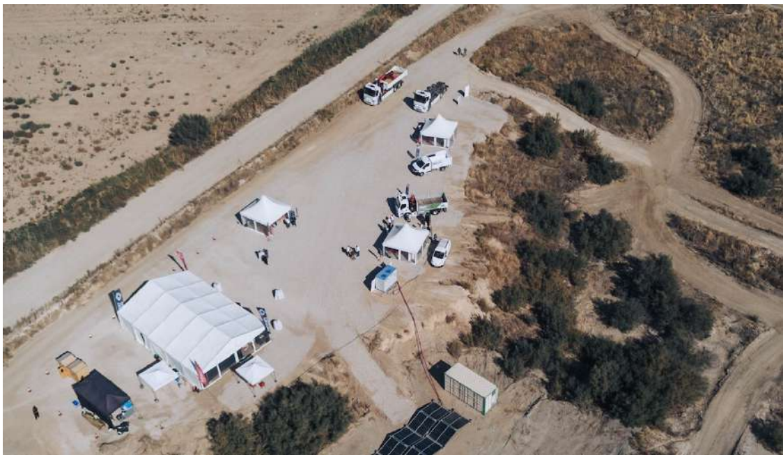
full&fast lanza la microrred solar móvil que quiere revolucionar las obras del sector de la construcción
