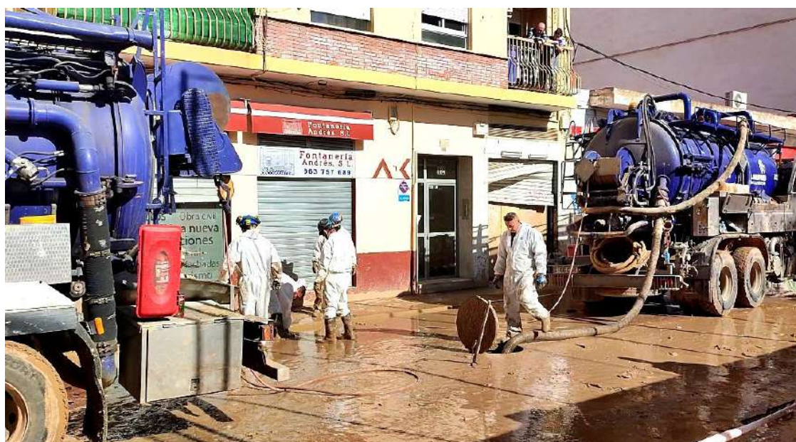
Trabajos de limpieza del alcantarillado afectado por la Dana en Benetússer. - Foto: AYUNTAMIENTO DE BENETÚSSER
