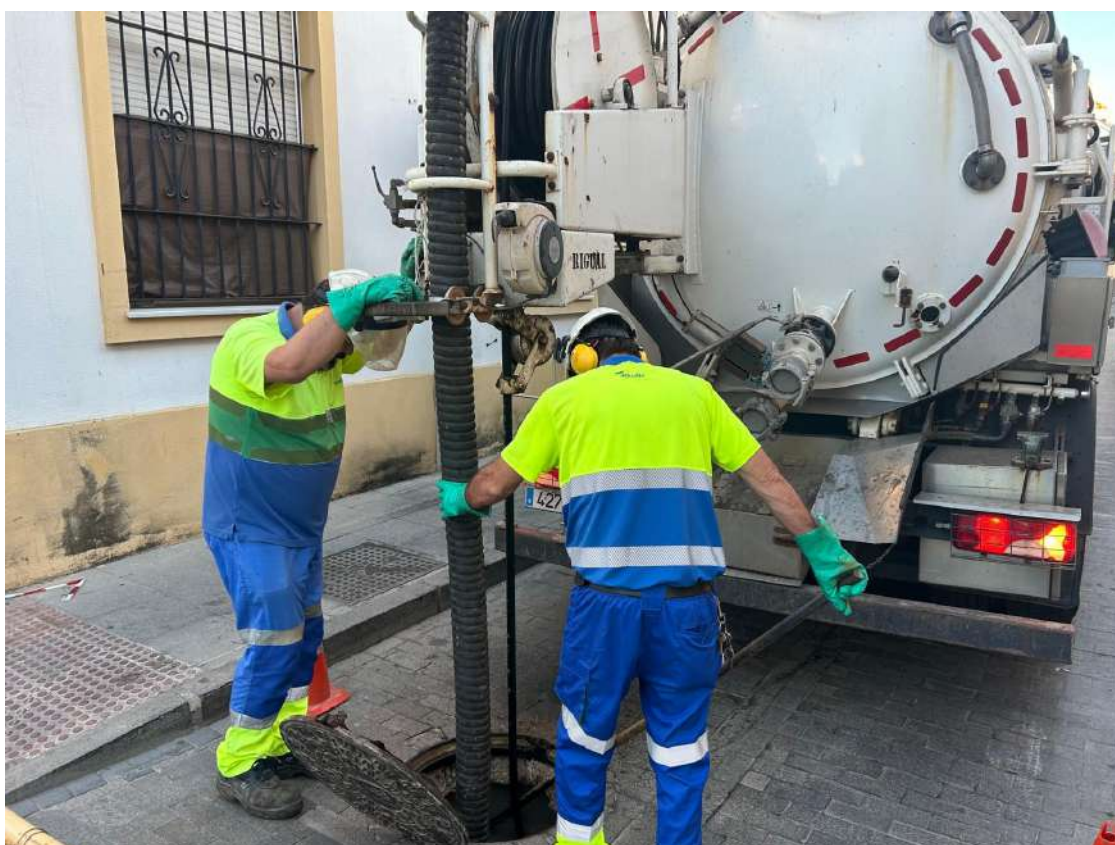
Continúan los trabajos de limpieza preventiva de las redes de saneamiento.
